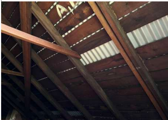
Timber roof slats
