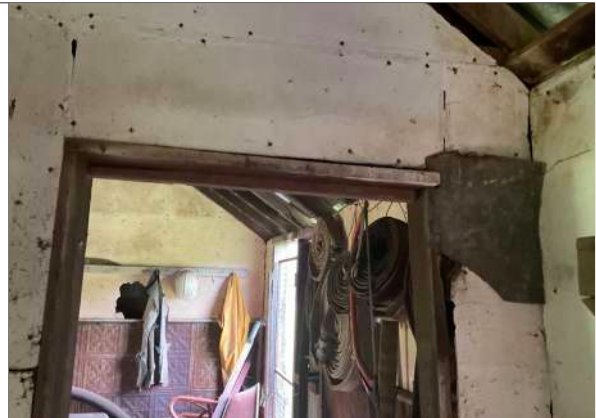
Internal door frame
