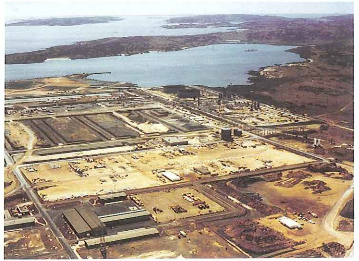
10. Industry — LNG plant.
