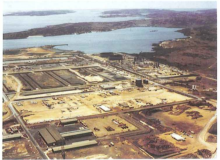
10. Industry — LNG plant.
